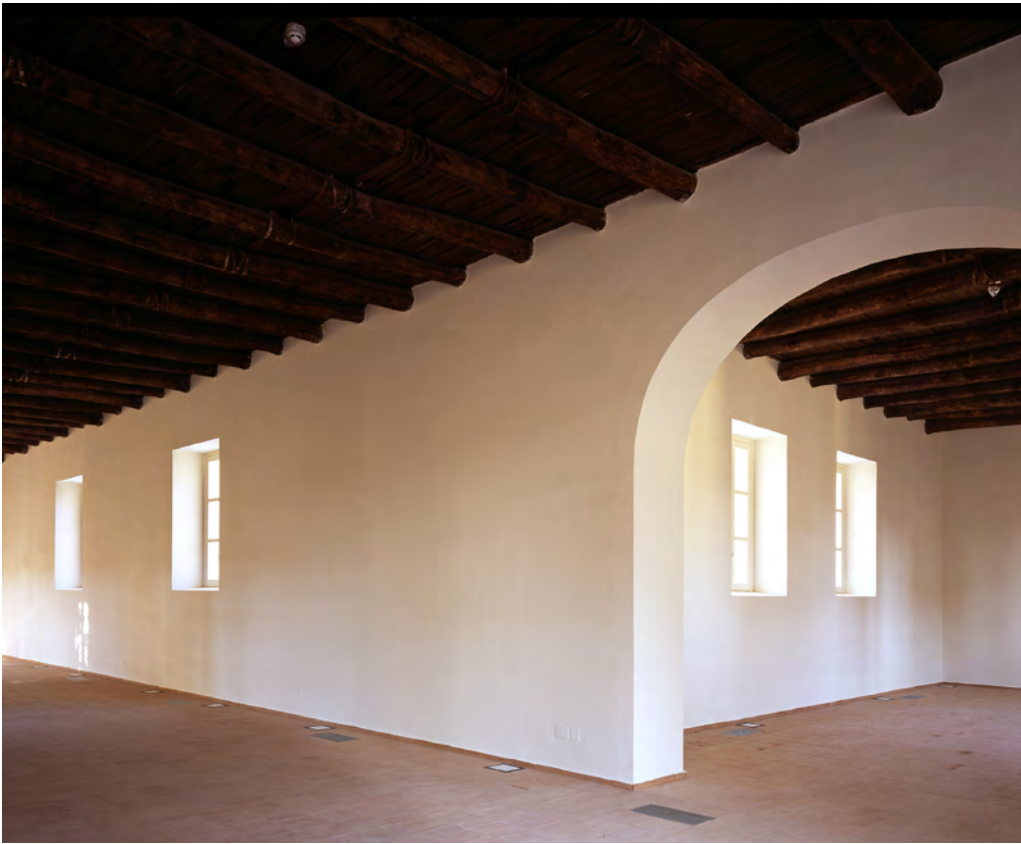
Il recupero delle travi in legno
