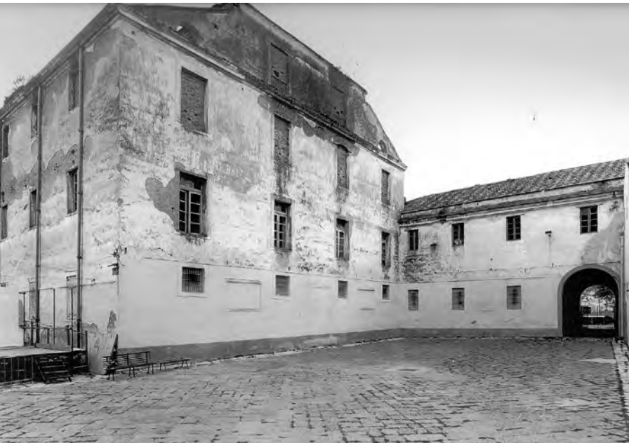
Corte 2: stato di fatto
