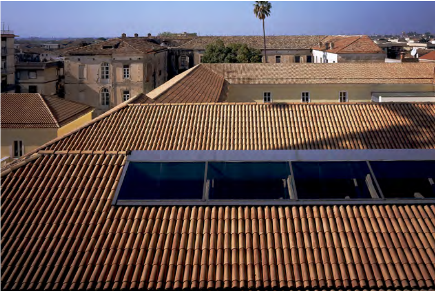
Il ripristino delle coperture
