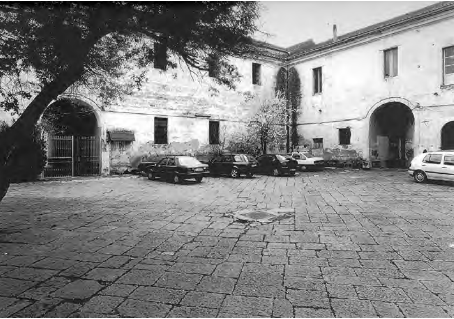
Corte 1: stato di fatto
