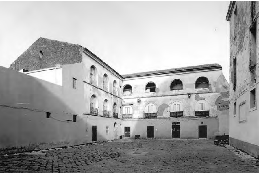
Corte 2: stato di fatto
