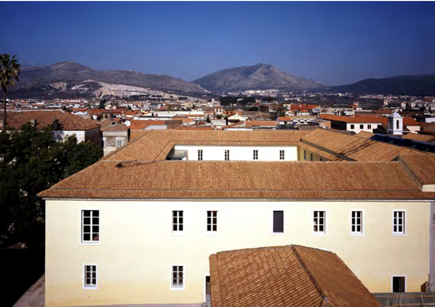
Il ripristino delle coperture
